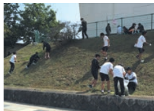
構内道路の斜面 (H30.06.09)
