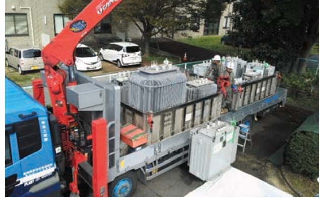
低濃度PCB廃棄物搬出状況(H29.10.18)
