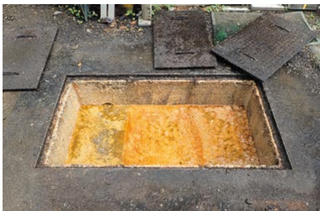
改修前のグリーストラップ(H29.06.26)
