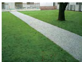
写真1：施工後（排水性地盤上に芝生、中央に複層の排水性舗装）
