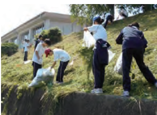
構内道路の斜面 (H29.06.10)
