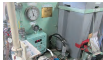
図4:逆浸透圧式造水装置
