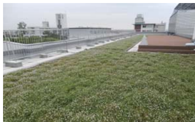
屋上に設置されたリビアの花壇
