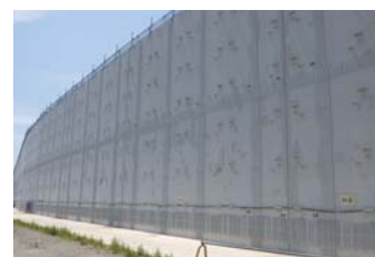
浜岡原子力発電所で工事中の防波壁
