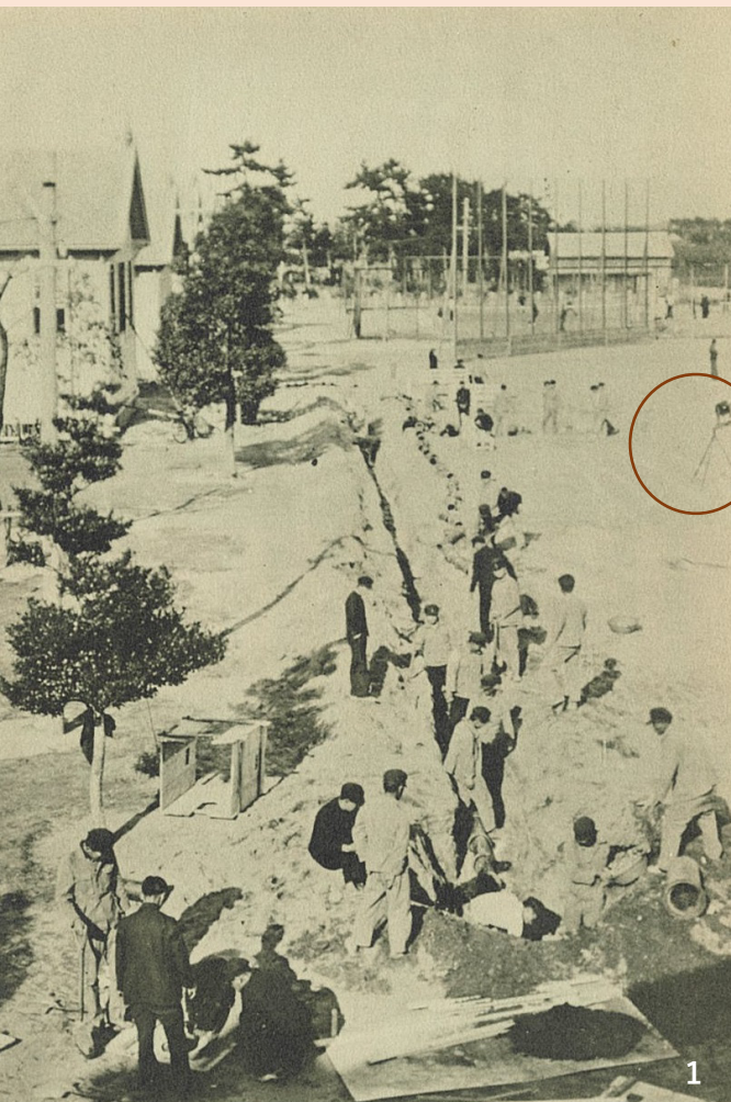
排水工事实習（南から） 1923年（※178-179頁間の写真）
