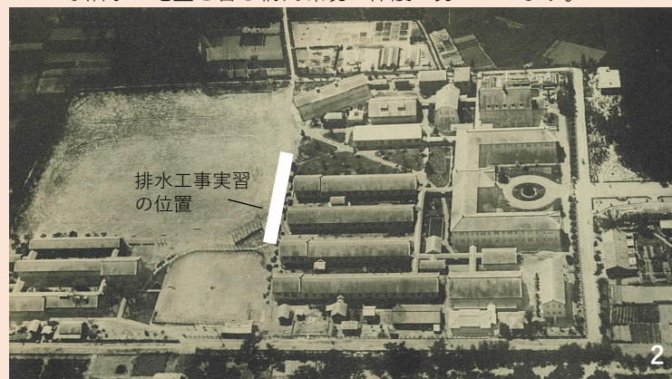
上空からの全景（北上空から）（※110-111頁間の写真）
