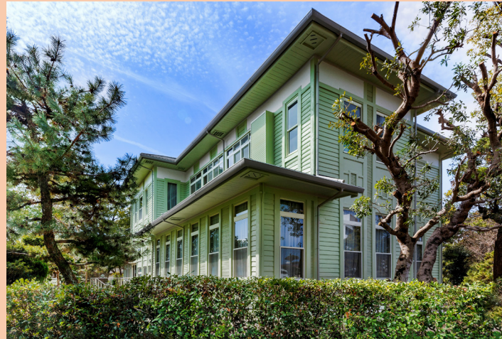
改修された三翠会館（2026年3月9日 南西から撮影）
