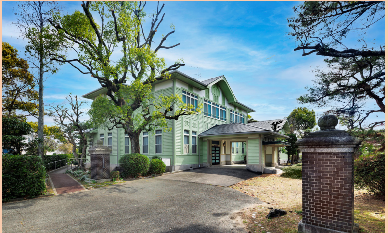
改修された三翠会館と門柱（2026年3月9日 北から撮影）
