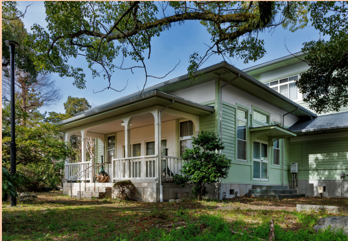
改修された三翠会館（2026年3月9日 南から撮影）
