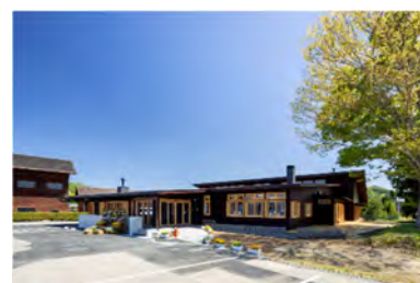
写真 8 みえ森林・林業アカデミー新棟 (写真提供:三重県)
