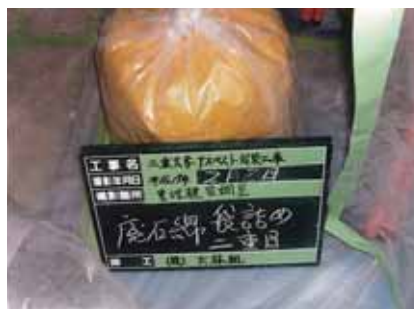
除去した吹付け材はこのように専用の袋に回収
