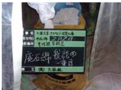
撤去後のアスベストの袋入れ作業
