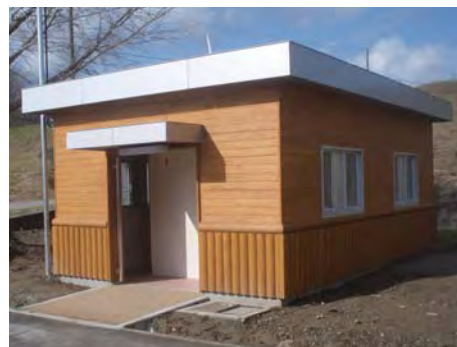
間伐材を利用した附属農場の便所外壁
