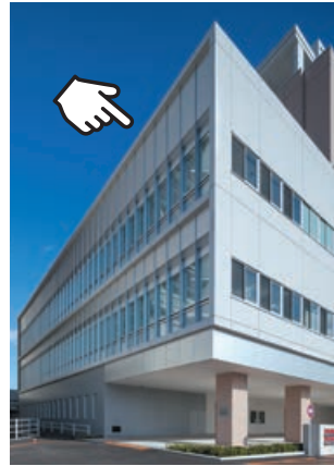
写真左壁面が電動ブラインド (H26.12.02)
