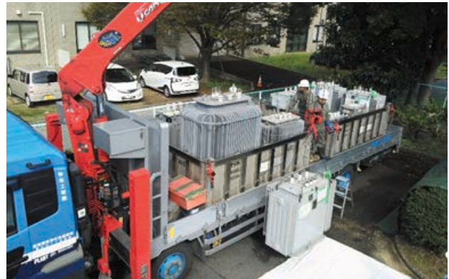
低濃度PCB廃棄物搬出状況(H29.10.18)
