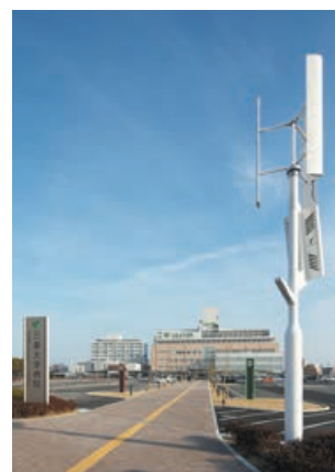
ハイブリッド(風車+太陽光パネル) LED照明(H30.03.06)
