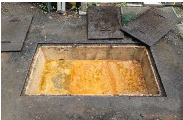
改修前のグリーストラップ(H29.06.26)
