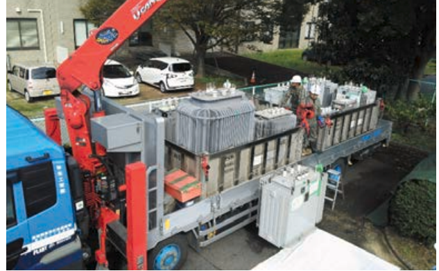
低濃度PCB廃棄物搬出状況(H29.10.18)
